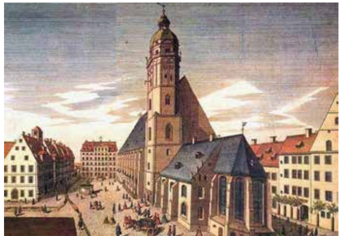
Thomasschule – hinten – und Thomaskirche in Leipzig
