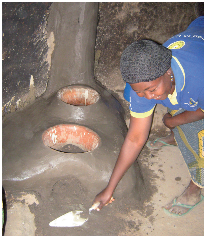
BAU EINES ENERGIEEFFIZIENTEN OFENS
