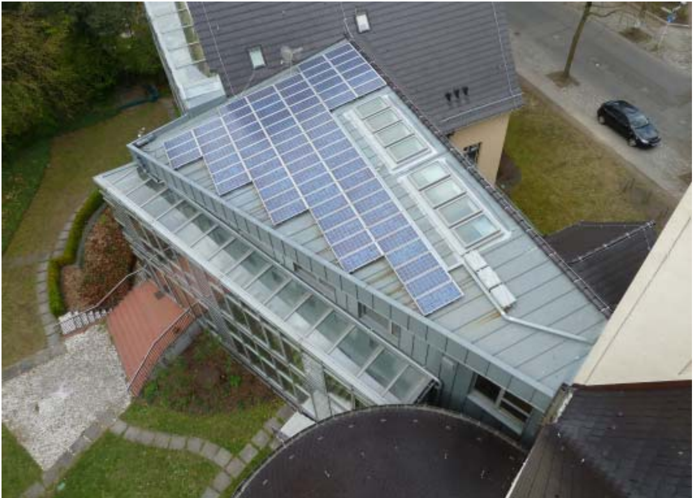
Die Photovoltaik-Anlage auf dem Dach des Gemeindezentrums - zu dem Beitrag zum Jahresthema auf S. 5.
